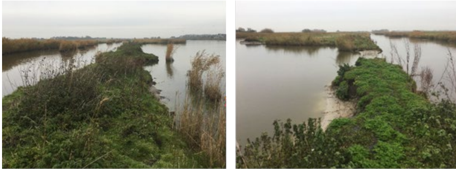
Figuur A5-1: Doorbraak van een waterscheidende dijk in de Hoge Zandskijl op Texel als gevolg van enkele jaren ganzenbegrazing en -betreding (foto's: Loran Tinga, Natuurmonumenten).
